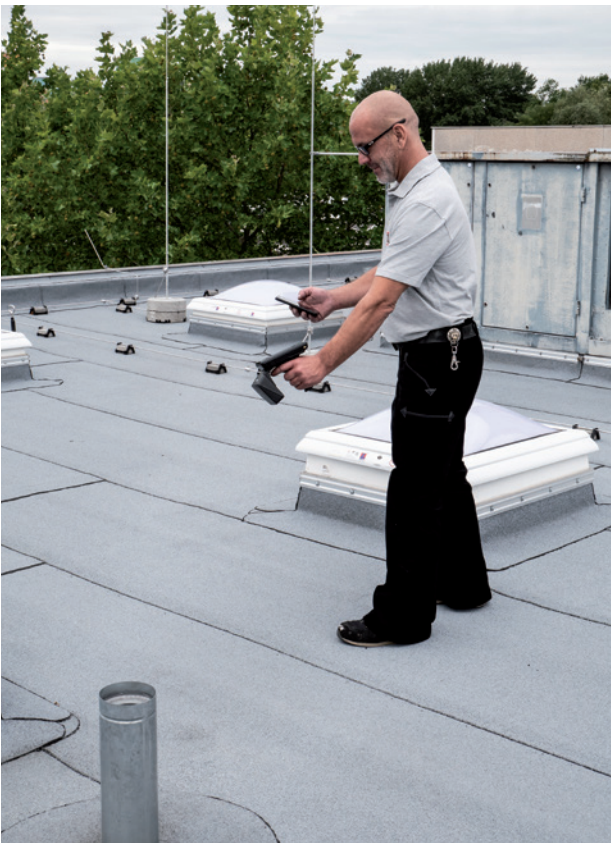
Egal ob Neubau oder Sanierung: Die Sensoren können in fast alle Flachdacharten integriert werden. Die Kontrolle passiert quasi im Vorbeigehen. Foto: HUM-ID GmbH
